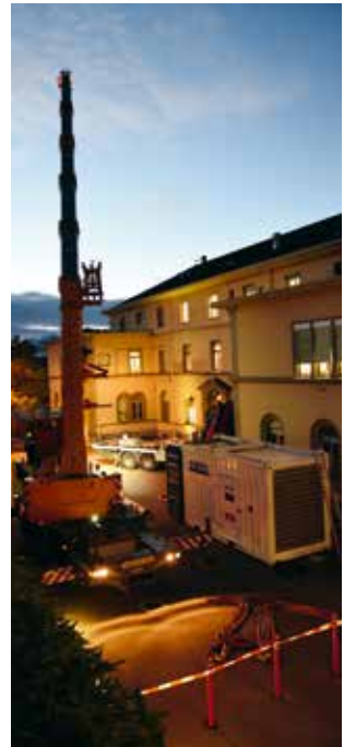
Installation d'une génératrice de secours
